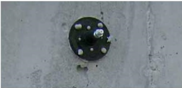
Figure 1: appliquer l'injecteur en applique au milieu de la fissure.
